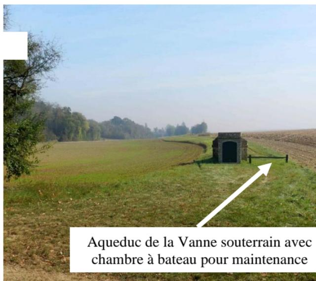
Aqueduc de la Vanne souterrain avec chambre à bateau pour maintenance
